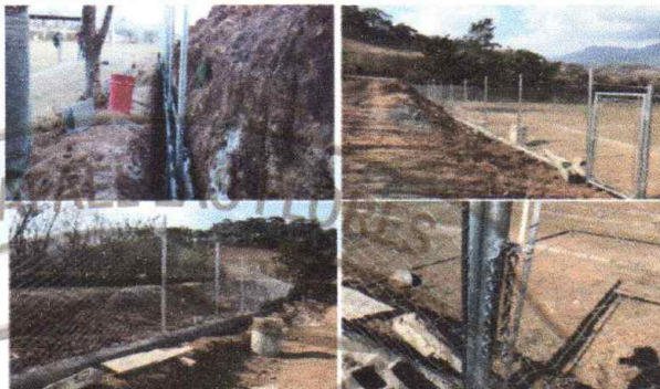
Cerramiento de 31 metros lineales, de muro perimetral con malla
